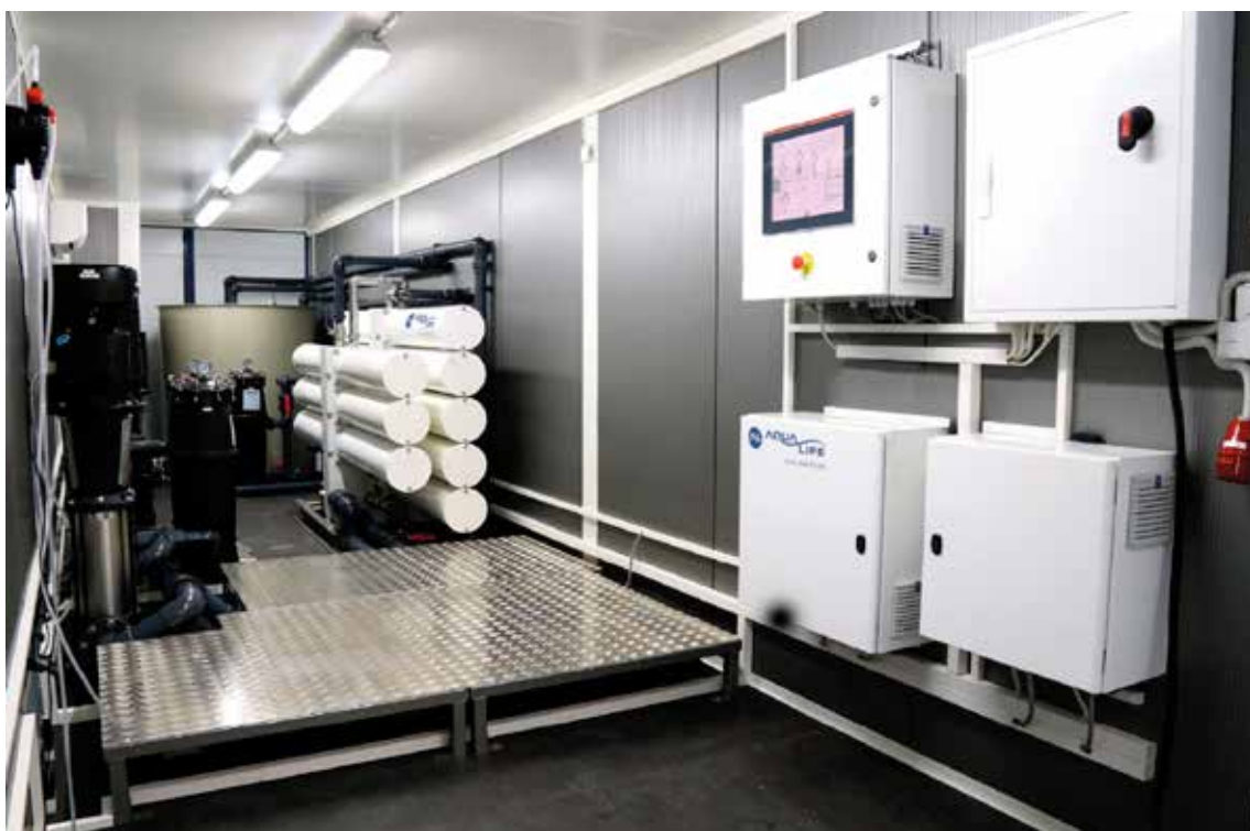
پلنت اسمز معکوس از آب شور چاه (۳۵ متر مکعب در ساعت) - انگلستان
